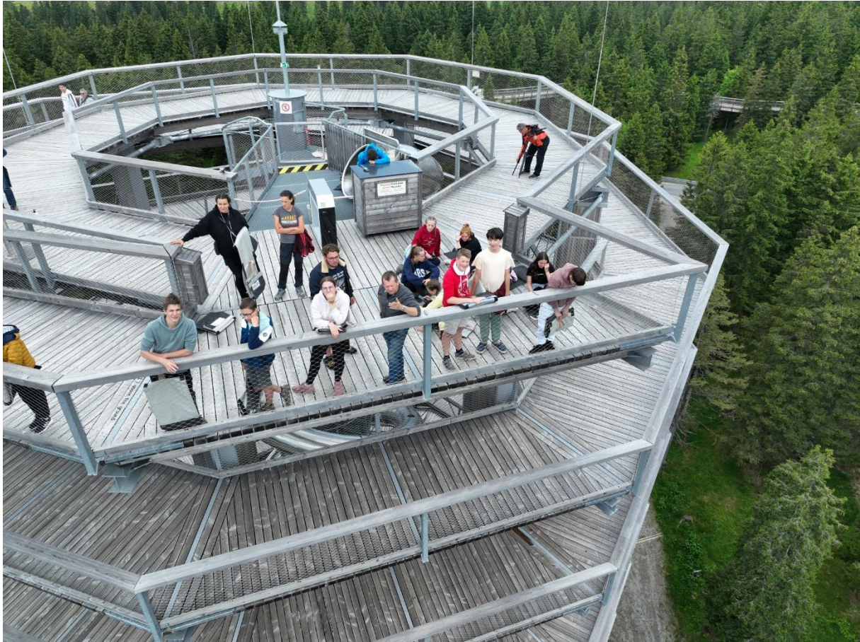
Slika št. 9: Na razgledni ploščadi (foto Srečko Štajnbaher)
