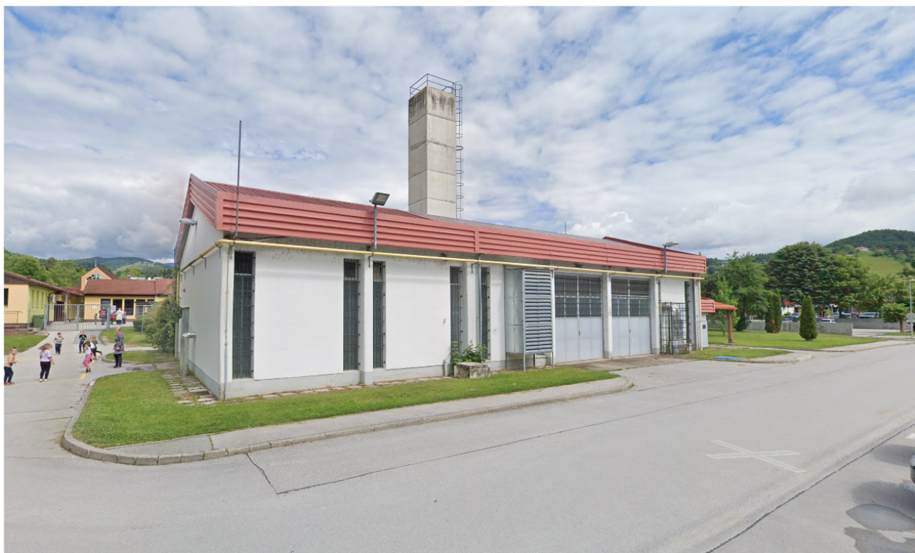
Slika 4: Fotografija območja obstoječe kotlovnice v smeri vzhoda (vir: Google maps, nov. 2024)
