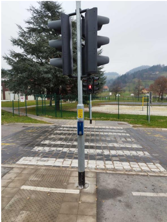
Slika 3 in 4: Ureditev zvočne signalizacije na semaforju pri prehodu pri OŠ Zreče
