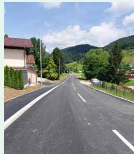
Izvajalec del je z deli pričel v marcu 2022 in glavnino del končal v zastavljenem roku, tj. do 6. 6. 2022. Potrebno je izvesti še komisijski pregled in končni obračun del.
