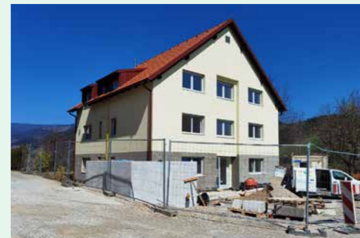
Nov 6-stanovanjski objekt na Mladinski ulici
