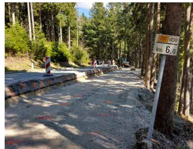
Sanacija usada pod Roglo
